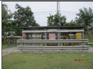
รูปที่ 3-50 สถานีควบคุมความดันและวัดปริมาณก๊าซ
