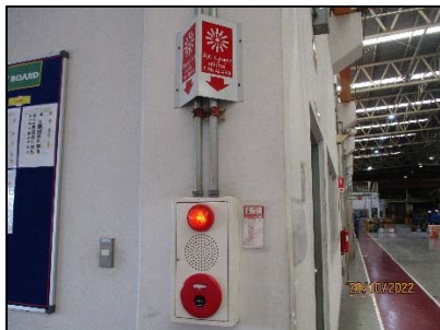
รูปที่ 3-41 ระบบตรวจจับและสัญญาณเตือนภัยอัตโนมัติ
