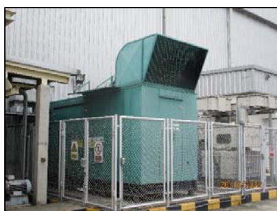
รูปที่ 3-53 เครื่องผลิตกระแสไฟฟ้าสำรองขนาด 700 kVA รูปที่ 3-54 เครื่องผลิตกระแสไฟฟ้าสำรองขนาด 600 kVA สำหรับโครงการโรงงานผลิตเส้นลวดทองแดงที่ไม่มีออกซิเจน สำหรับโครงการโรงงานผลิตเส้นลวดทองแดง ที่มีออกซิเจน
