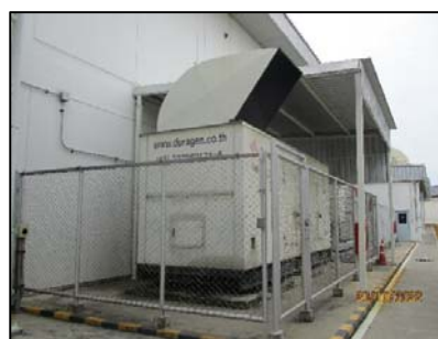
รูปที่ 3-53 เครื่องผลิตกระแสไฟฟ้าสำรองขนาด 700 kVA รูปที่ 3-54 เครื่องผลิตกระแสไฟฟ้าสำรองขนาด 600 kVA สำหรับโครงการโรงงานผลิตเส้นลวดทองแดงที่ไม่มีออกซิเจน สำหรับโครงการโรงงานผลิตเส้นลวดทองแดง ที่มีออกซิเจน
