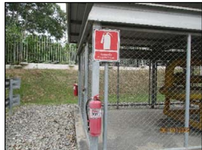
รูปที่ 3-48 เครื่องดับเพลิงชนิดผง (Powder Extinguisher)
