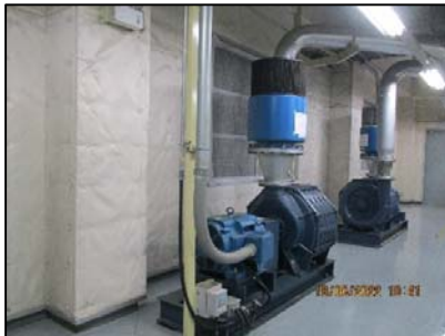
รูปที่ 3-14 การปิดครอบเครื่องจักรและอุปกรณ์ที่มีเสียงดัง และผนังกันเสียง
