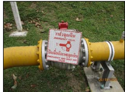
รูปที่ 3-46 ระบบท่อ Bypass และระบบวาล์วสำรอง
